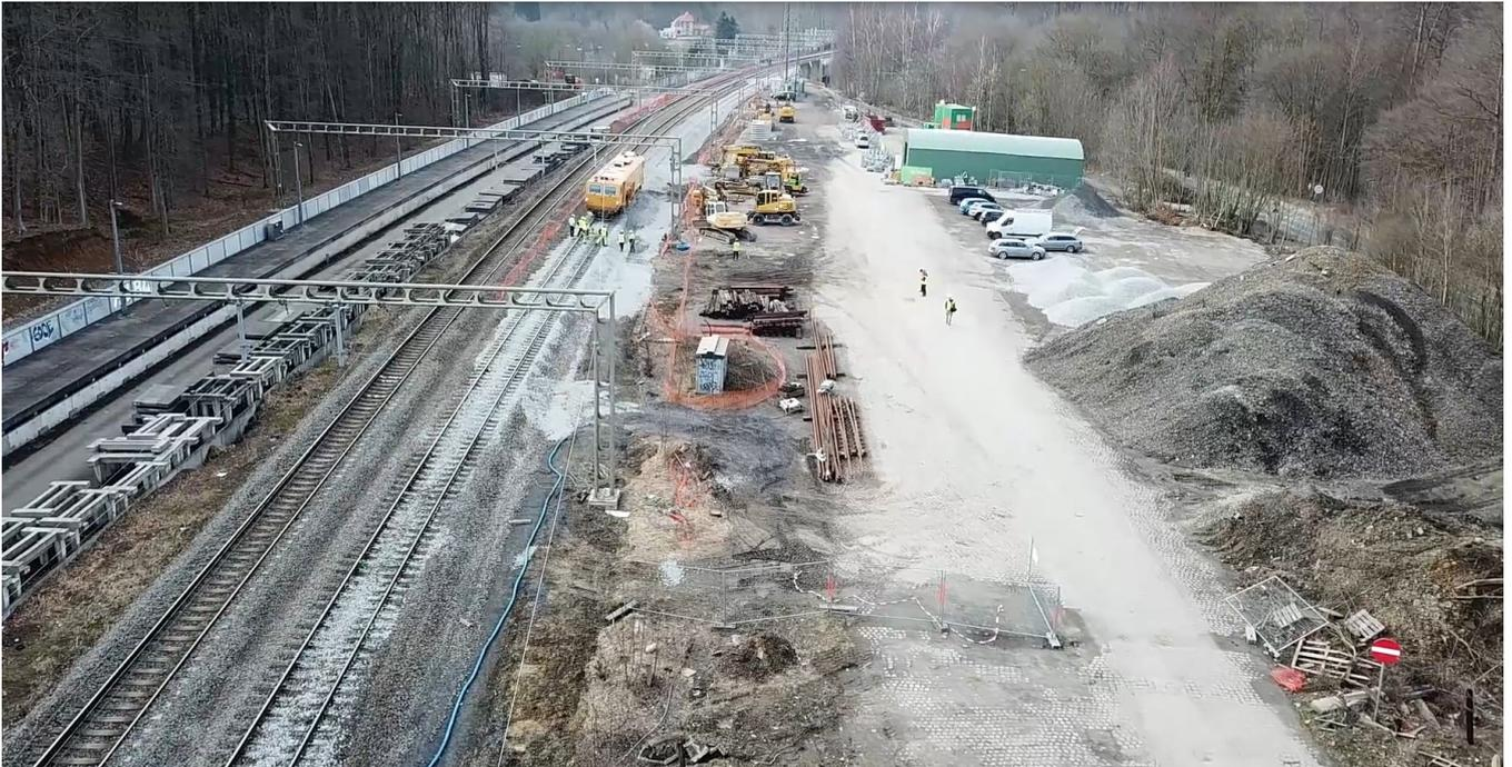
Le RER – Réseau Express Régional – repose sur la mise à 4 voies de 5 axes ferroviaires majeurs dans un rayon de 30km autour de Bruxelles. Cette capacité doublée permet de faire circuler les trains rapides sur les deux voies centrales, sans interaction avec des trains locaux qui circulent, eux, sur les deux voies latérales. L'offre aux voyageurs est ainsi étendue avec la possibilité de faire circuler un train local tous les 1/4h.
